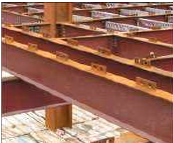
Figura 13 – Viga mista com Perfobond (VM-2).
