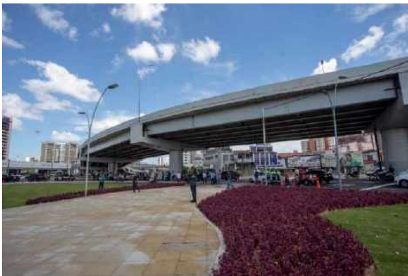
Figura 4 – Viaduto Av. Aguanambi, em Fortaleza-CE.
