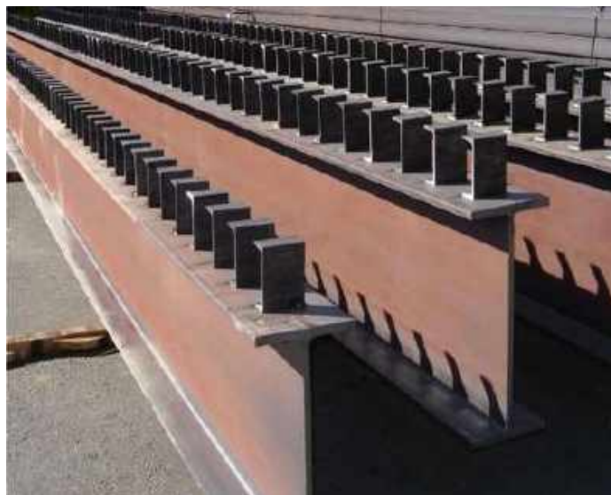
Figura 14 – Viga mista com Perfil “U” (VM-3).
