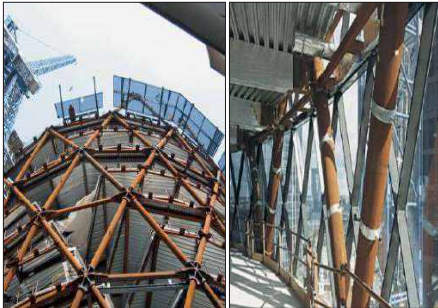
Figura 11 - Edifício St Mary Axe situado em Londres
