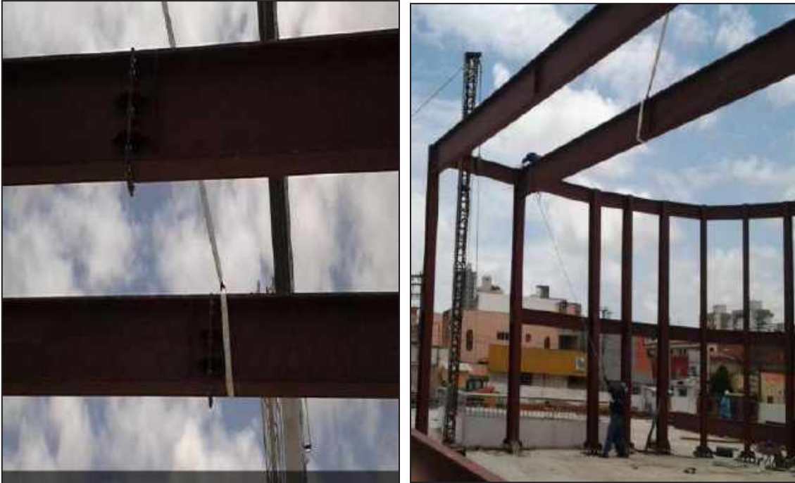
Figura 22: Viga do Auditório no período da construção
