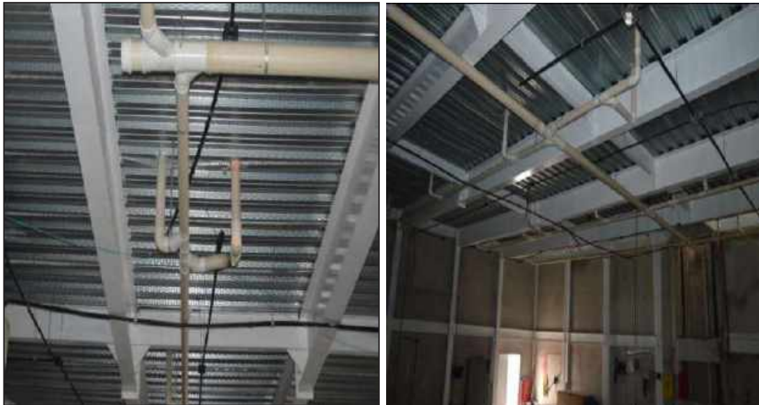
Figura 21– Laje Stel deck de Aditório do Edifício CREMEC
