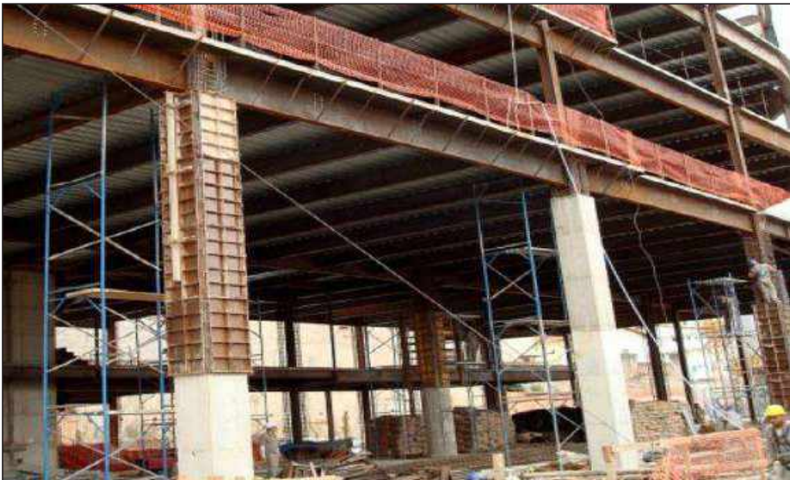
Figura 5 - Aplicação dos sistemas mistos em estruturas verticais
