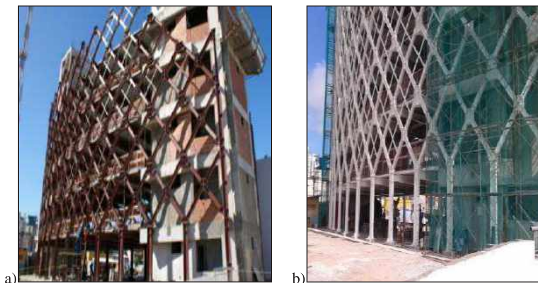
b) Imagem do canteiro com 60% da obra concluída
