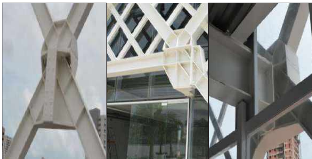
Figura 30 - Modelo desenvolvido dos nós que formam o diagrid do CREMEC.
