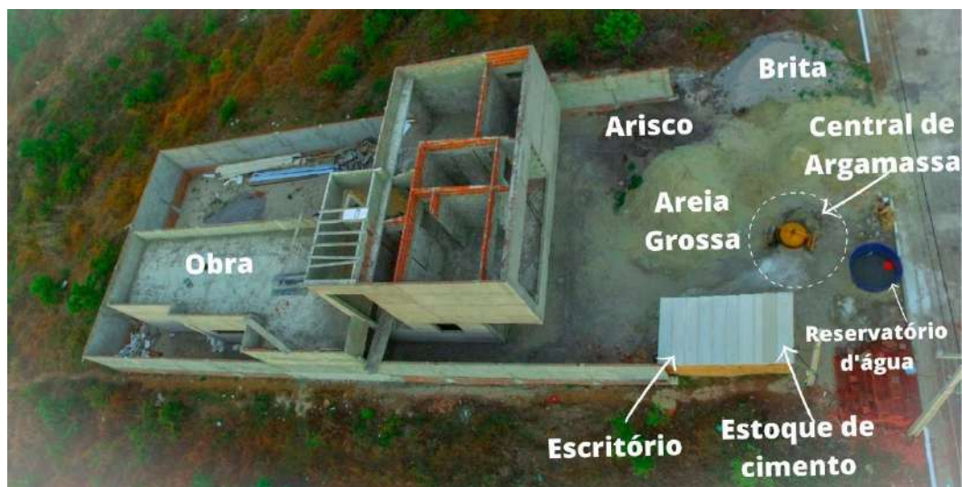
Figura 5: Canteiro de obra.
