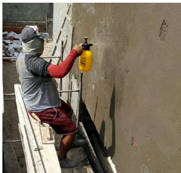
Figura 9: Pulverizador para humedecer reboco.
