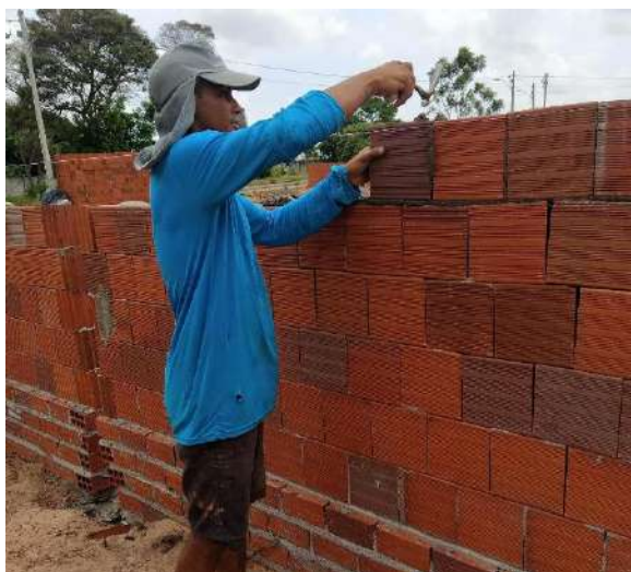
Figura 4: Assentamento de blocos uniformes com Argamassa polimérica.
