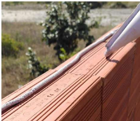
Figura 8: Execução de alvenaria com argamassa polimérica.
