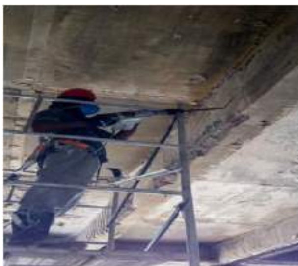
Figura 7-Apicoamento de superfície de concreto
