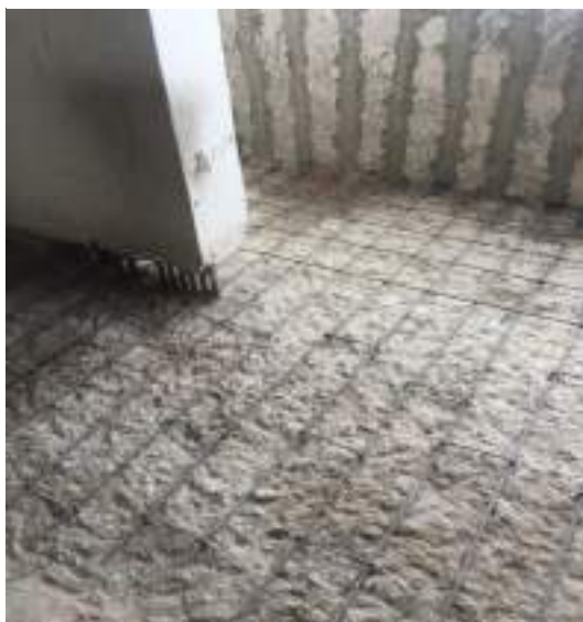
Figura 25- Recuperação estrutural de varanda de concreto armado
