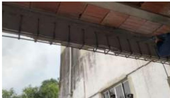
Figura 5- Fixação química.
