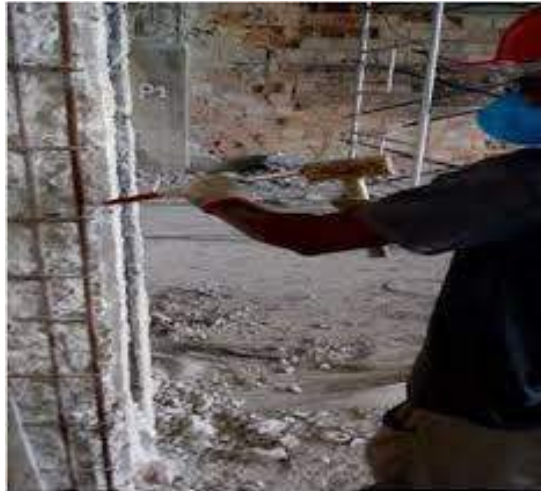
Figura 18- Apicoamento manual de superfície de concreto
