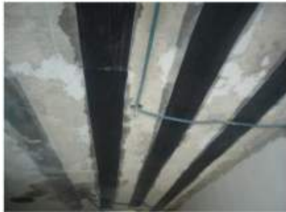
Figura 27- Reforço de lajes com fibras de carbono
