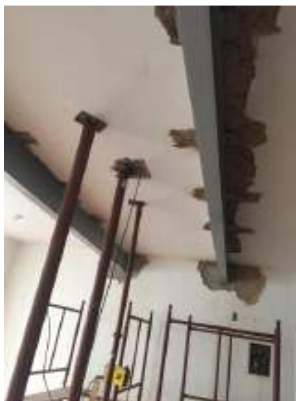
Figura 30- Projeto e execução estrutural em sala comercial-Niterói/RJ
