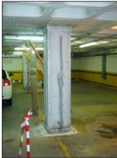
Figura 20- Encamisamento de um pilar com chapas metálicas
