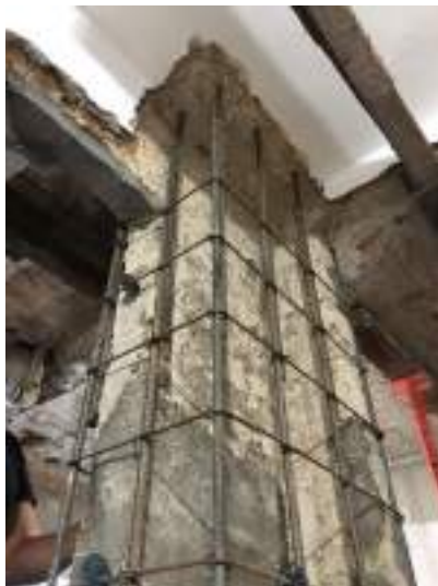
Figura 17- Execução de recuperação e reforço de pilar de concreto
