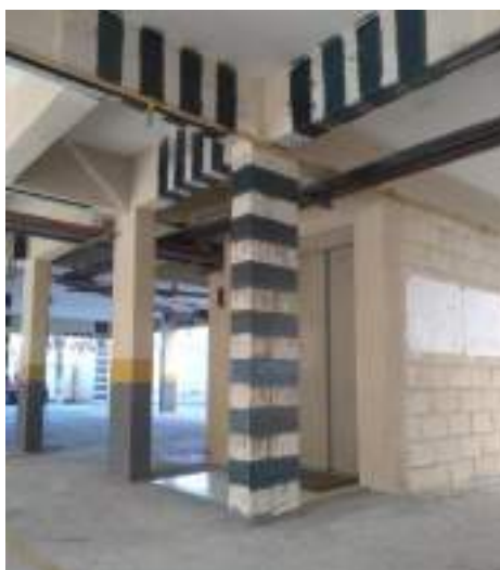
Figura 24- Reforço estrutural com manta de fibra de carbono
