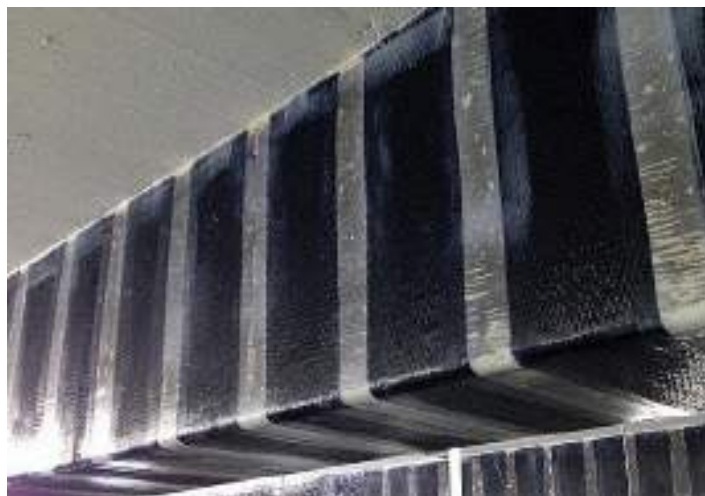
Figura 11-Reforço estrutural em viga com fibra de carbono
