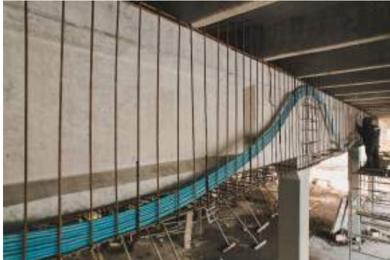
Figura 14- Reforço estrutural em concreto protendido.
