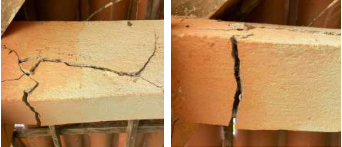
Figura 3- Viga fissurada
