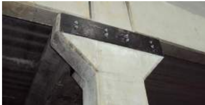
Figura 8- Reforço com chapa de aço colada
