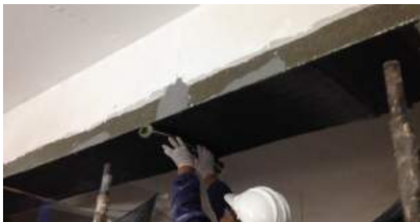
Figura 12-Reforço estrutural com fibras de carbono em indústria
