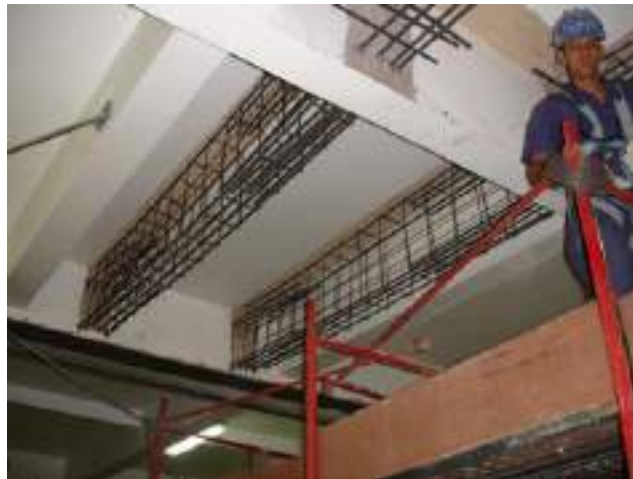
Figura 26- Reforço de estruturas
