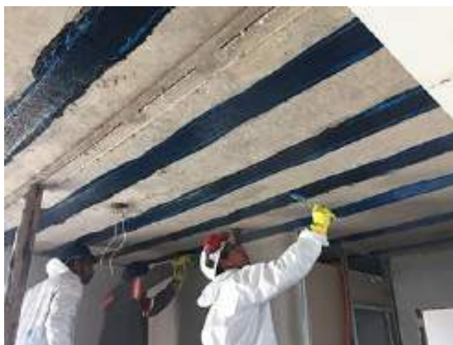
Figura 28- Reforço com fibras de carbono
