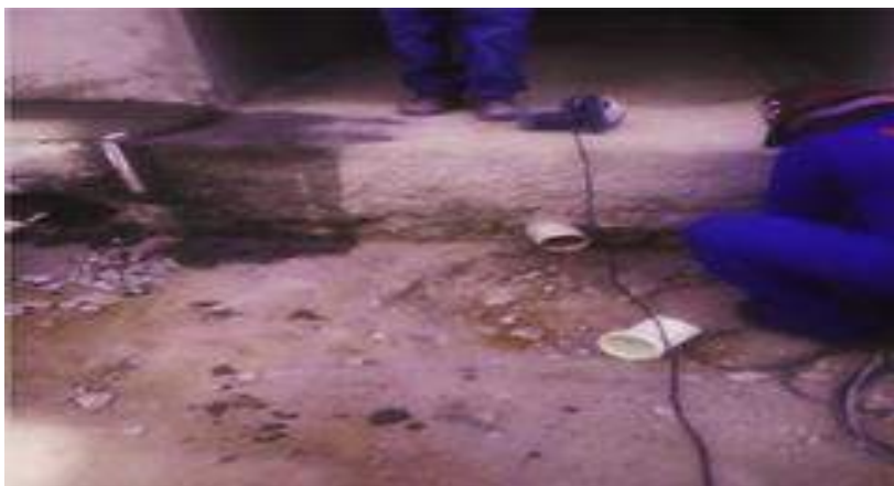
Figura 3: Calçada de acesso ao bloco de apartamentos sem meios que facilitem o acesso
