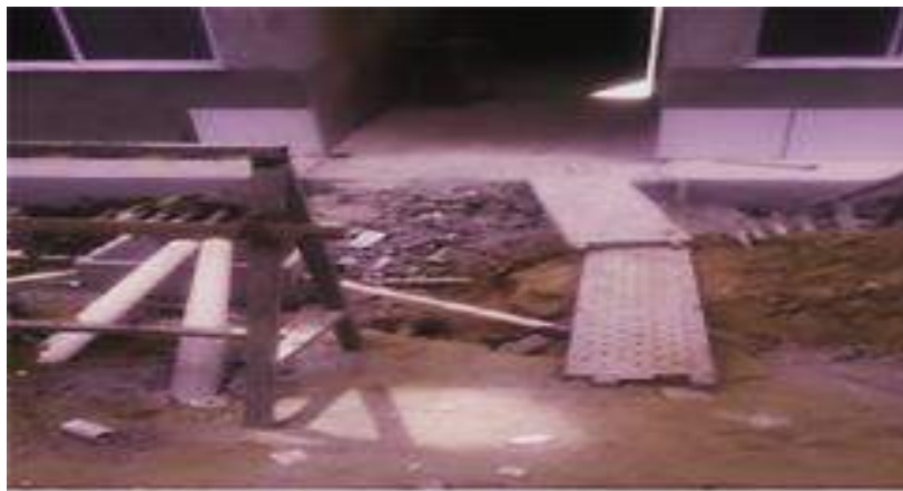
Figura 4: Improvisação de prancha metálica para construção de passarela e acesso ao bloco de apartamentos
