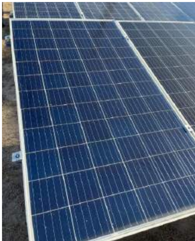
Figura 13 – Situação da placa em ótima condição.
