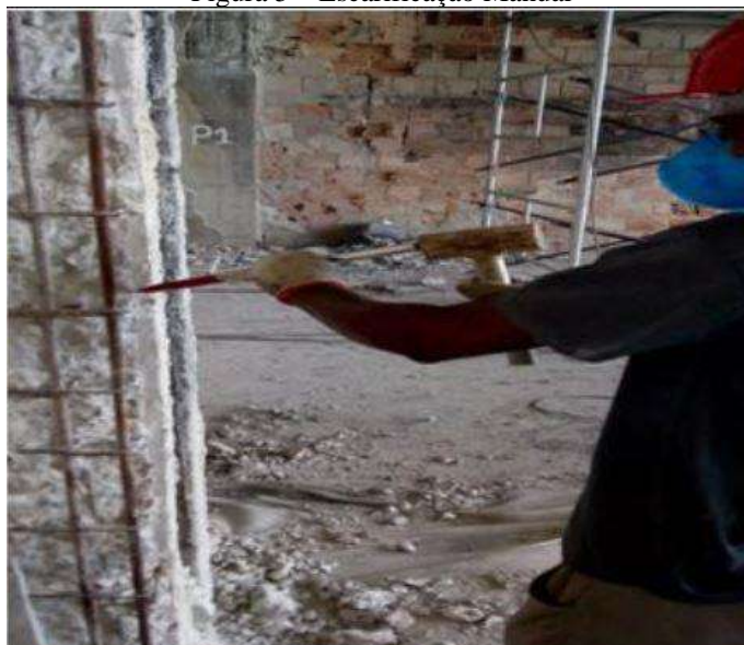
Figura 5 – Escarificação Manual
