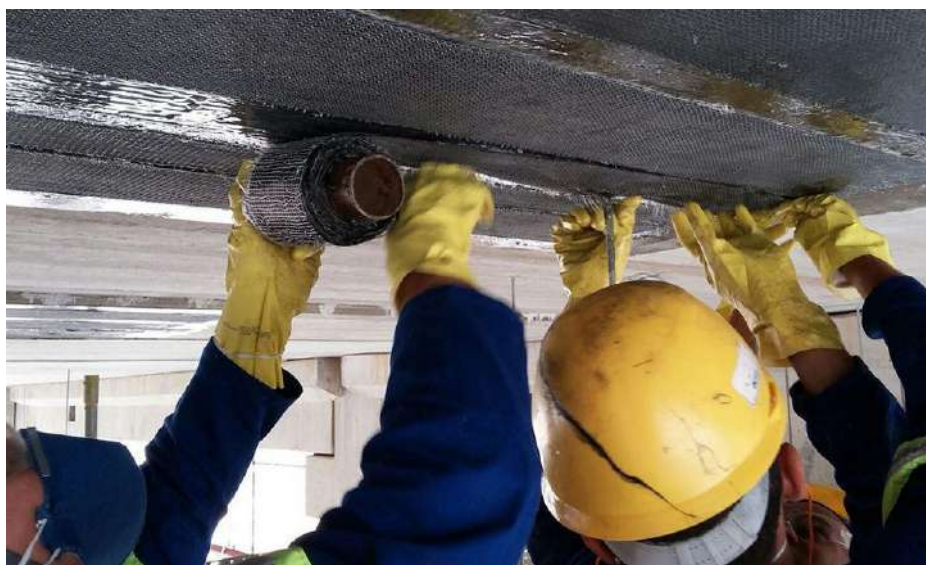
Figura 11 – Reforço Através de Fibra de Carbono
