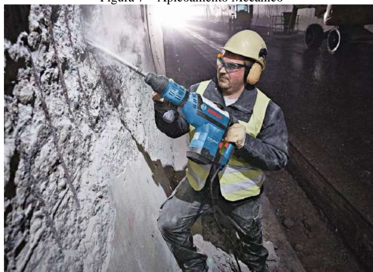
Figura 7 – Apicoamento Mecânico
