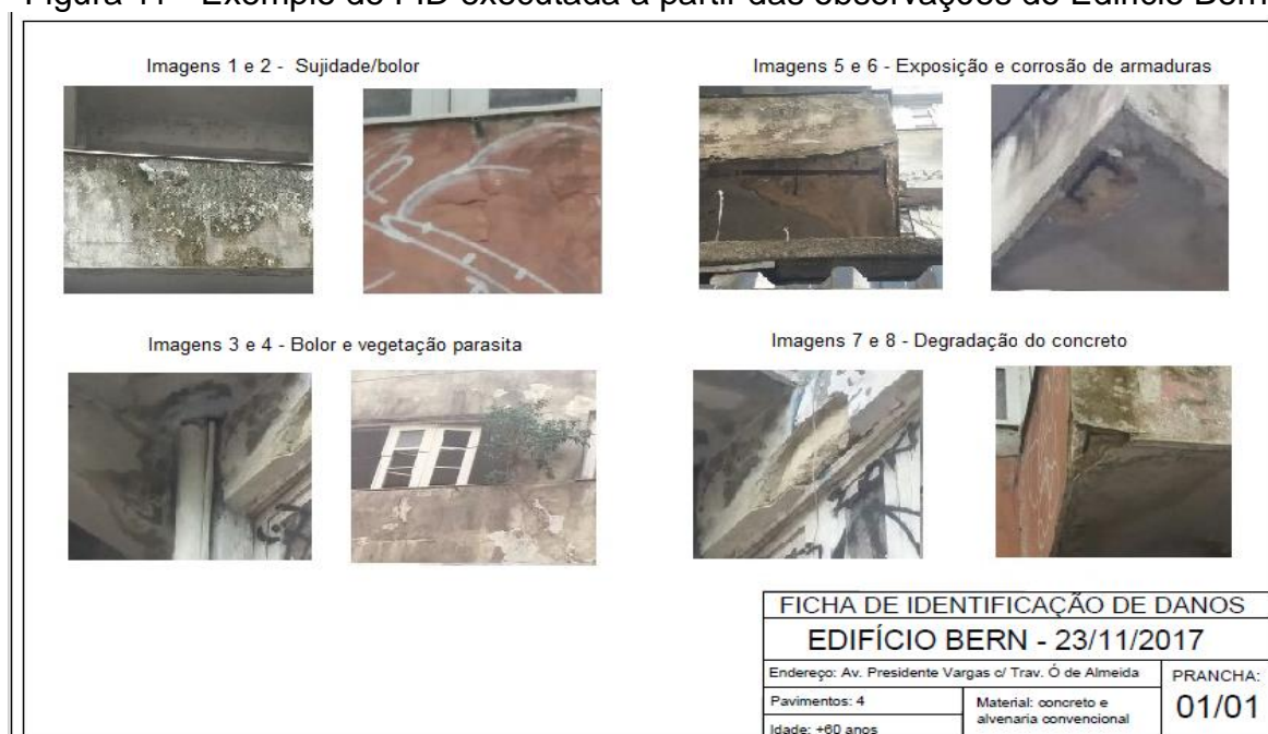
Figura 11 - Exemplo de FID executada a partir das observações do Edifício Bern.
