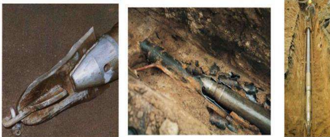
Figura 8 – Substituição de tubulação pelo método pipe bursting.
