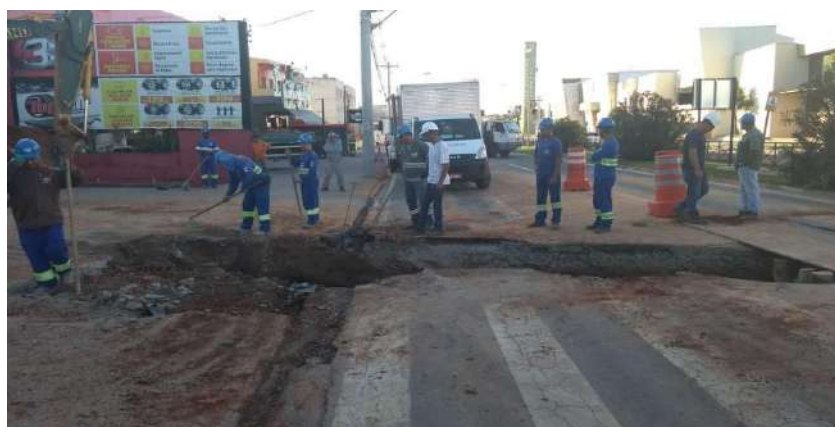
Figura 5 – Substituição parcial do trecho de uma tubulação.
