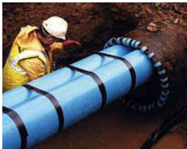
Figura 13 – Inserção do tubo Para reabilitação da tubulação existente.
