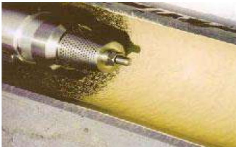
Figura 9 - Cabeçote de aspersão fazendo aplicação de resina epóxi.
