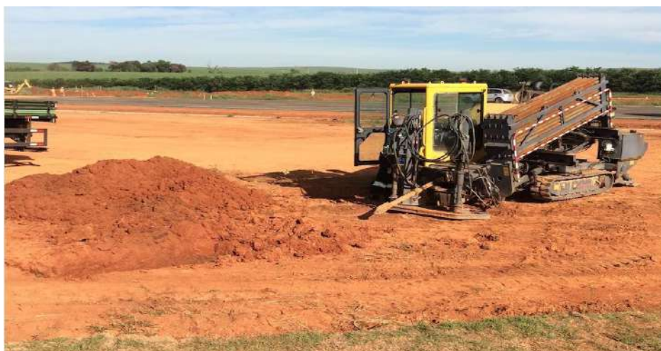
Figura 16 – Início de perfuração direcional.
