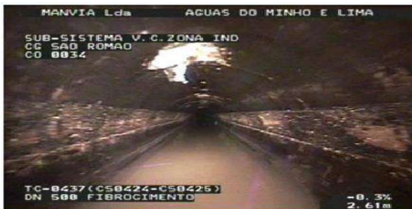
Figura 14 – Visita e análise interna de tubulação feita por robô.
