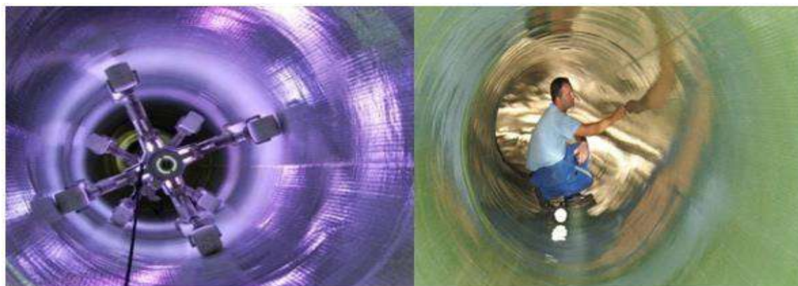
Figura 15 – Reabilitação de tubulação pelo CIPP com cura uv realizada por robô.
