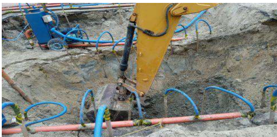
Figura 3 - Rebaixamento de lençol.
