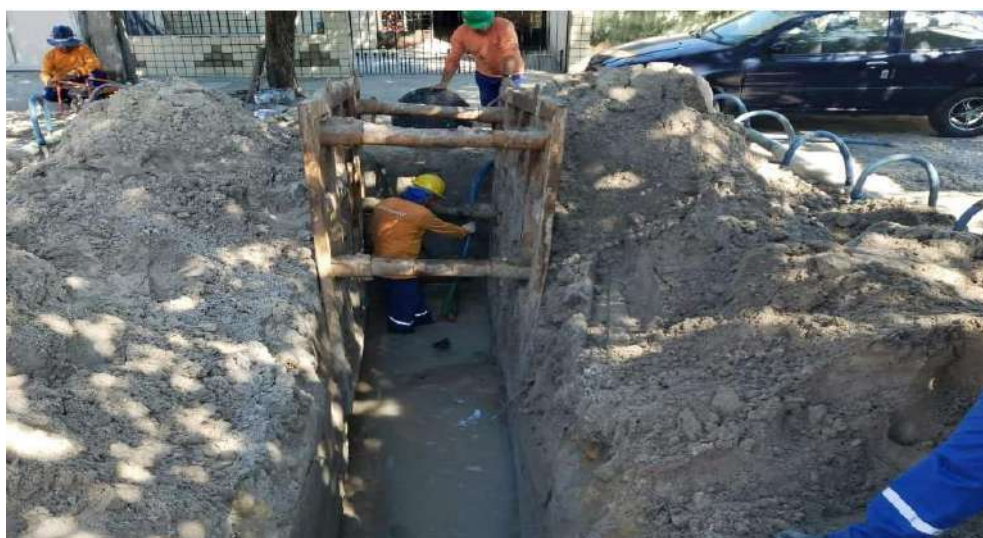
Figura 7 - Escoramento de vala com blindado pré-fabricado.
