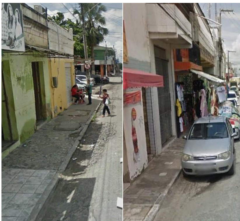
Figura 13 – Calçamento em rua pública
