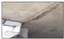
Figura 8 - Fissura em laje junto à escada
