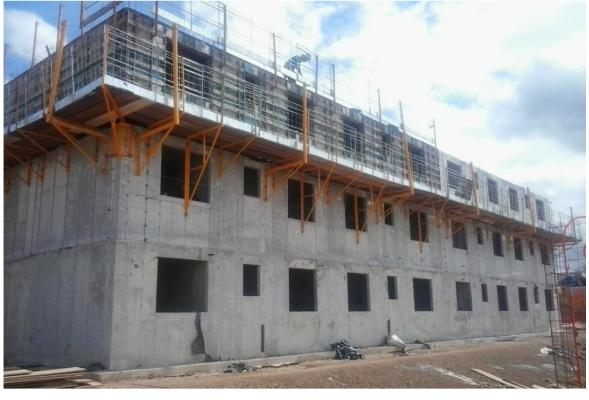
Figura 2 – Canteiro de obras de edificações de paredes de concreto
