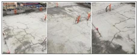
Figura 6 - Fissuras em laje por retração do concreto
