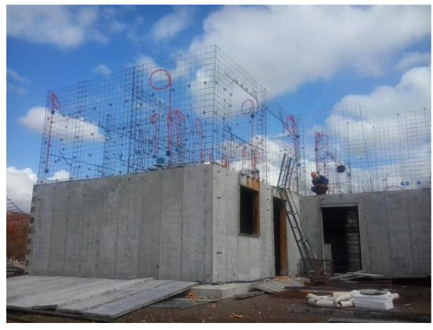
Figura 1 - Desmontagem das fôrmas e montagem da parte elétrica e estrutural
