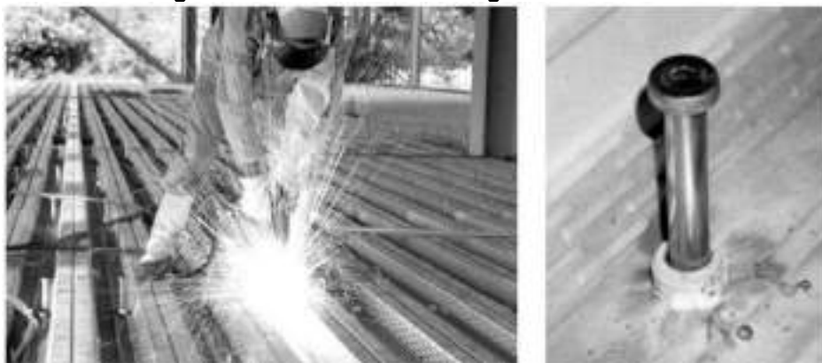
Figura 16 - Processo de soldagem do conector.
