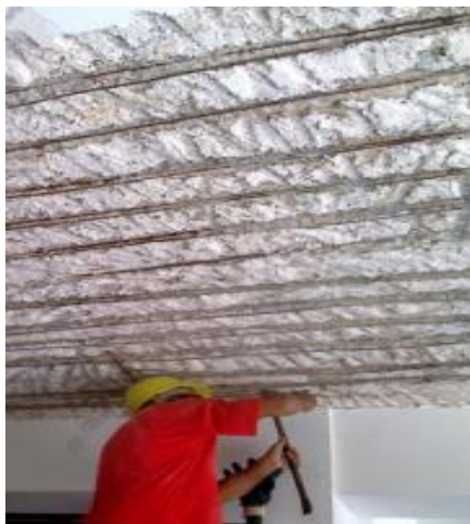
Figura 18: Escarificação na Laje
