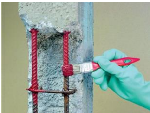
Figura 23: Proteção da armadura com pintura
