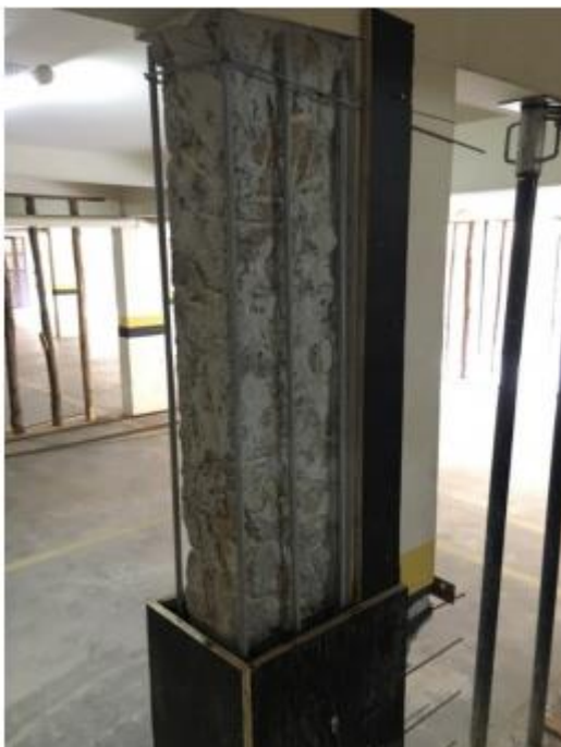
Figura 27: Encamisamento do pilar
