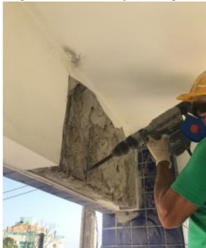
Figura 16: Escarificação da viga
