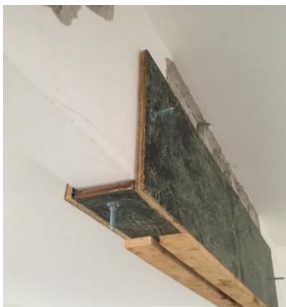
Figura 25: Fôrma fixada com parabol
