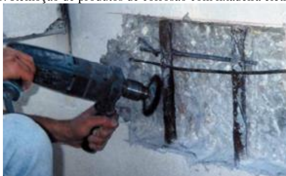
Figura 21: Remoção de produtos de corrosão com lixadeira elétrica
