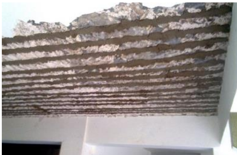
Figura 24: Aplicação de argamassa polimérica
