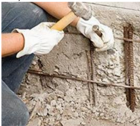
Figura 17: Remoção do concreto com o uso de martelo e talhadeira
