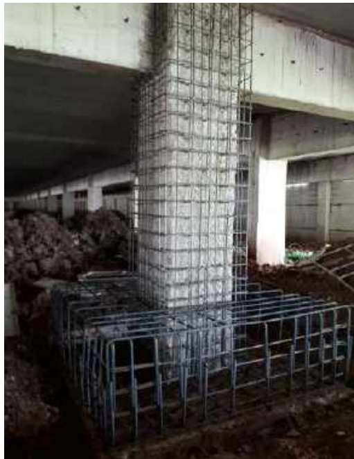
Figura 26 - Inserção das novas armaduras transversais e longitudinais.
