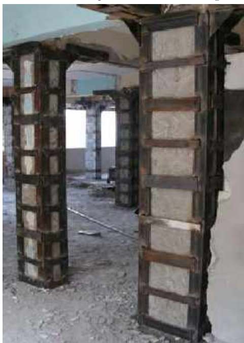
Figura 28 - Pilares reforçados através de chapas metálicas.
