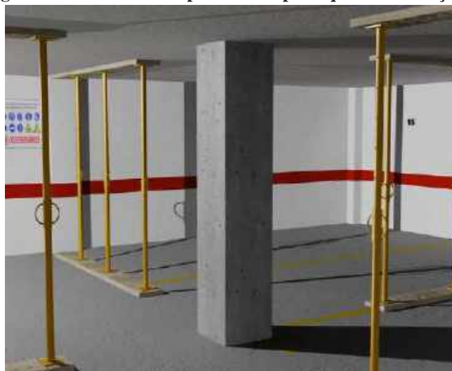
Figura 29 - Escoramento próximo de pilar que será reforçado.
