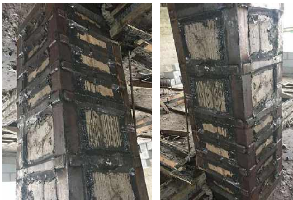
Figura 30 - Aplicação da resina epóxi para maior aderência das chapas.
