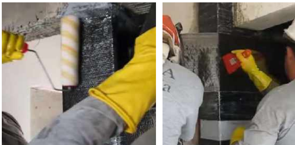
Figura 40 - Aplicação da resina sobre a primeira camada (esquerda) e aplicação da segunda camada (direita).
