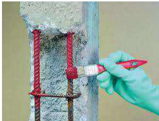
Figura 25 - Aplicação de produto neutralizador de corrosão.
