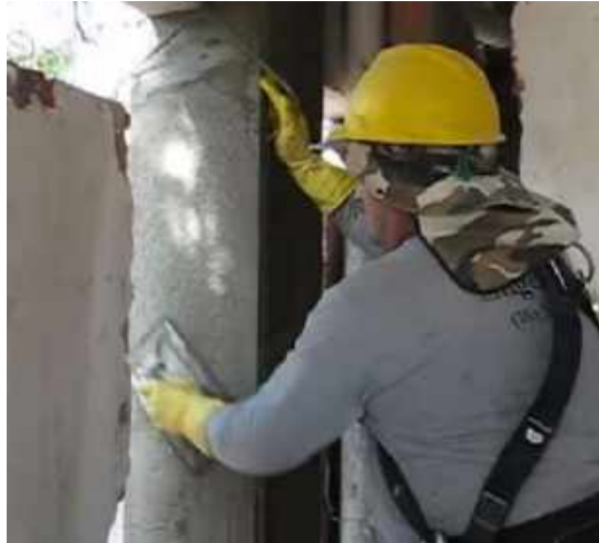
Figura 37 - Correção da superfície de concreto que receberá o reforço.
