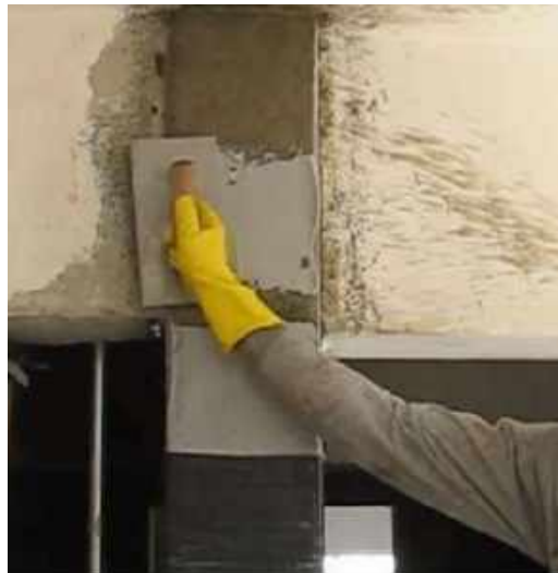
Figura 38 - Aplicação do imprimador epoxídico.
