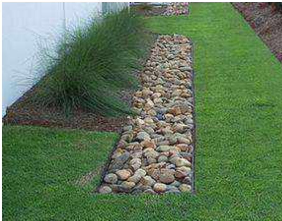
Figura 22 – Trincheira de infiltração
