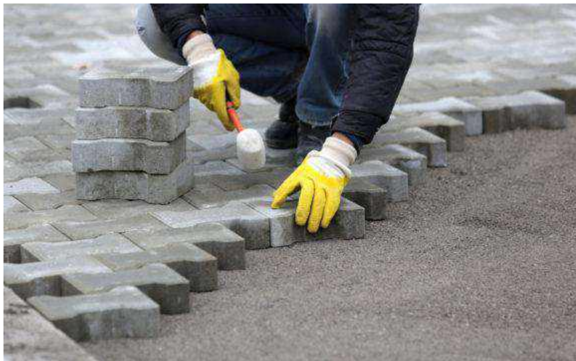
Figura 21 – Instalação de um pavimento permeável
