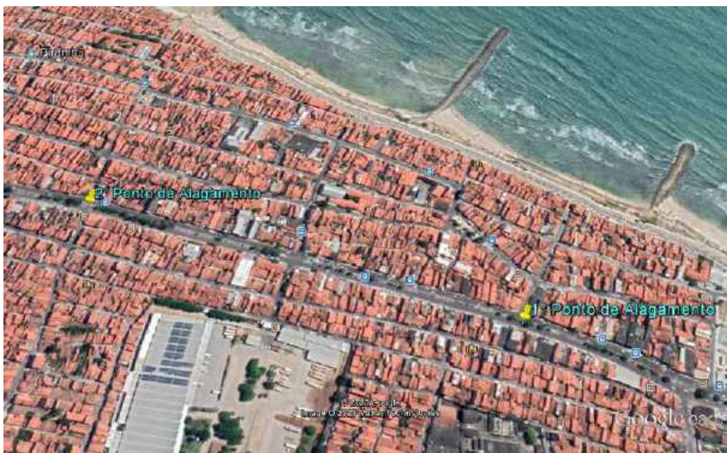
Figura 14 – Pontos de alagamento
