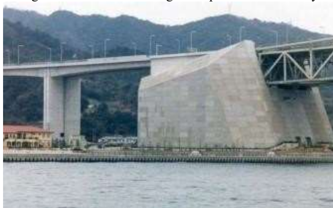
Figura 2 - Bloco de ancoragem da ponte Akashi Kaikyo
