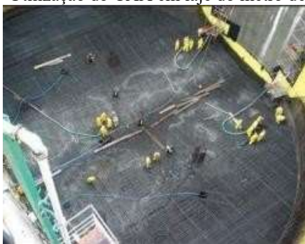
Figura 6 - Utilização do CAA em laje do metrô de São Paulo
