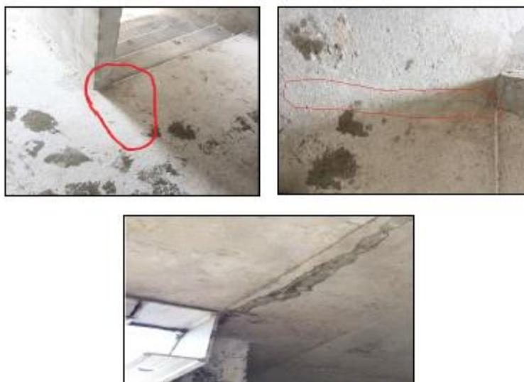
Figura 8 - Fissura em laje junto à escada
