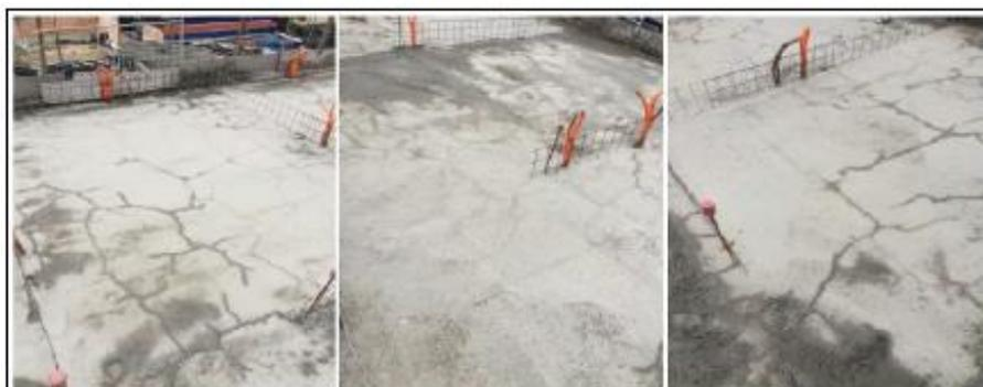
Figura 6 - Fissuras em laje por retração do concreto
