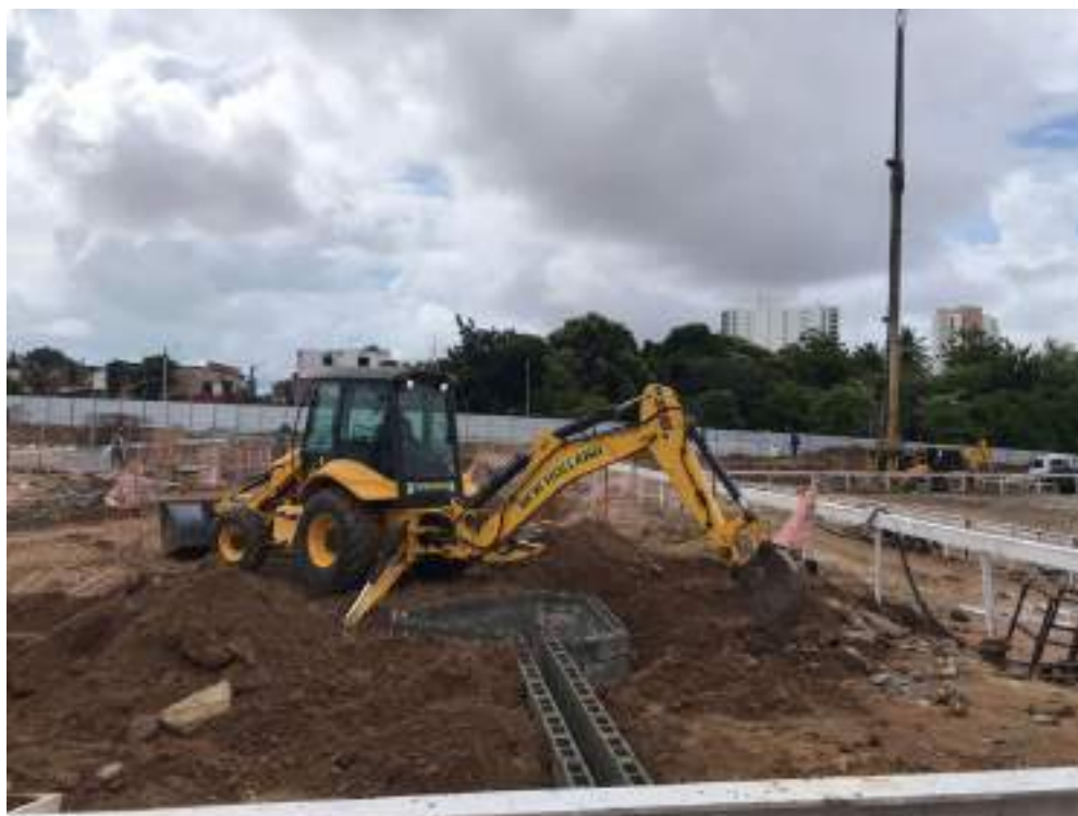
Figura 7: A obra na fase de fundação
