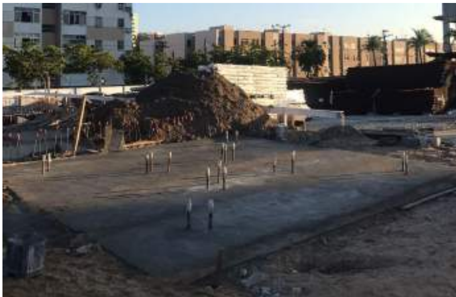
Figura 11: Base da grua e estoque de telas de aço
