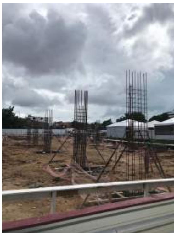
Figura 10: Execução de blocos de fundação e pilares
