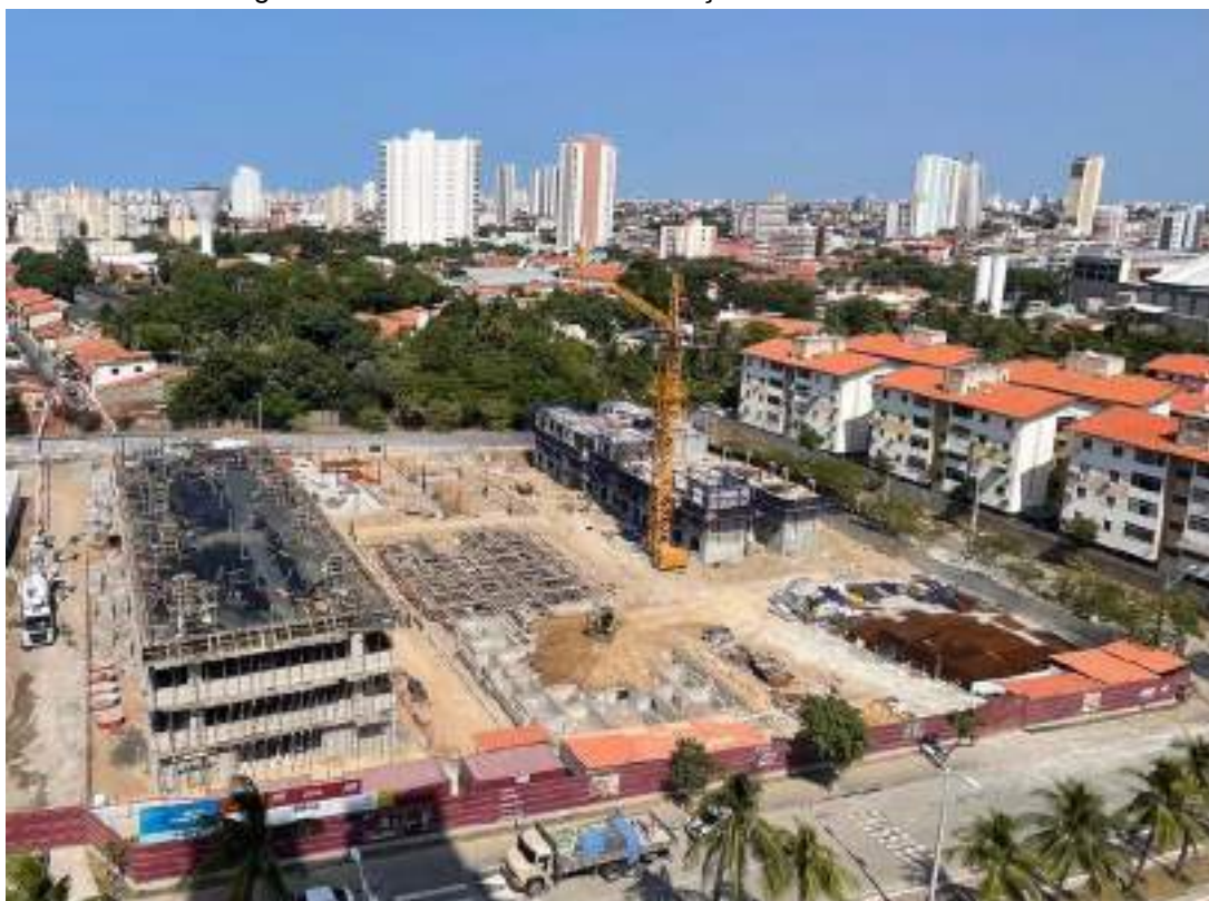
Figura 8: A obra nas fases de fundação e estrutura
