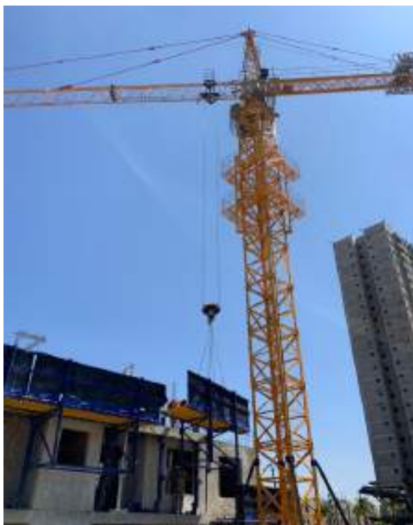
Figura 12: Grua em funcionamento
