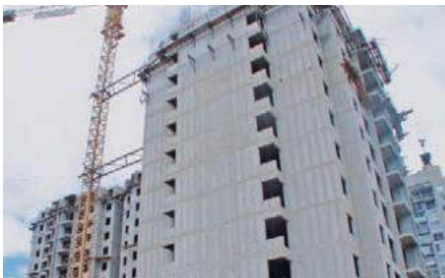
Figura 1: Edifício em parede de concreto
