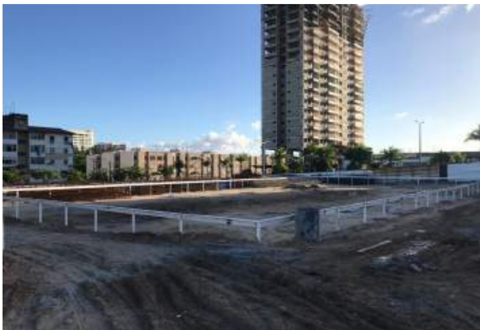
Figura 9: A obra em sua fase inicial
