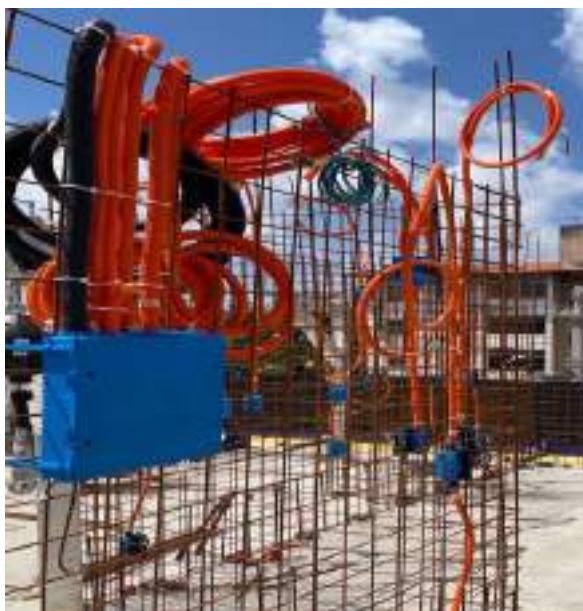
Figura 3: Armação e elementos de instalações
