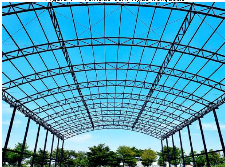
Figura 7 – Telhado com vigas treliçadas
