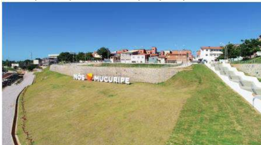
Figura 16 - Representação da camada de proteção superficial do talude
