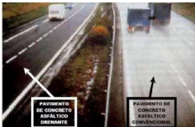
Figura 11- Formação de Névoa em Pavimento de Concreto Asfáltico Convencional, diferentemente da CPA
