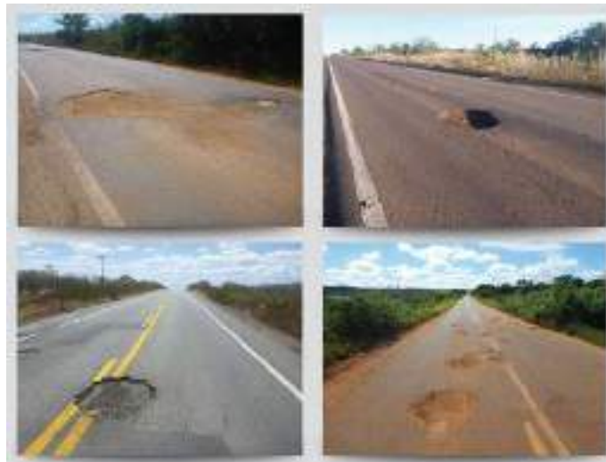
Figura 27 – Panela ou Buraco
