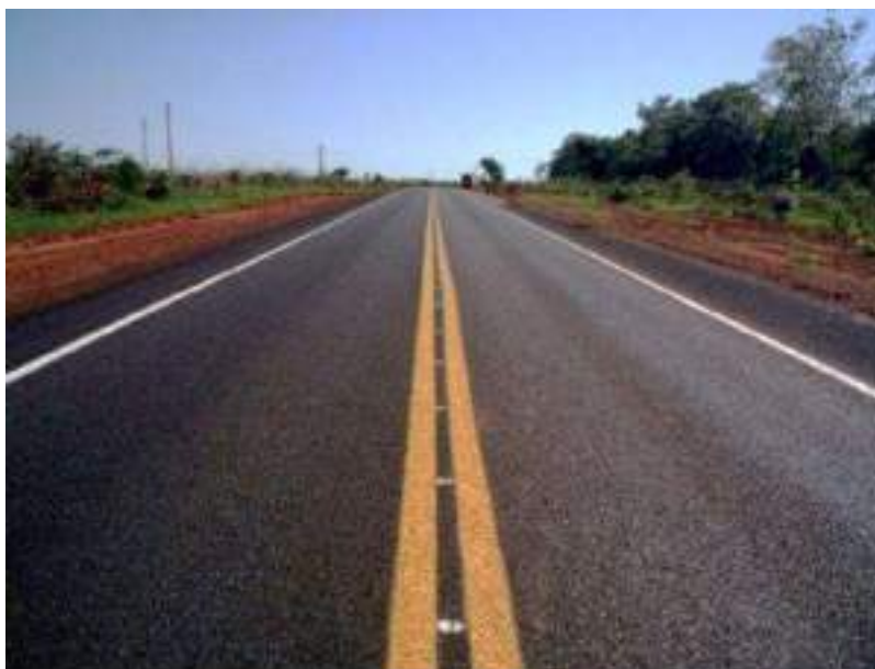
Figura 10 - Rodovia Pavimentada com CA
