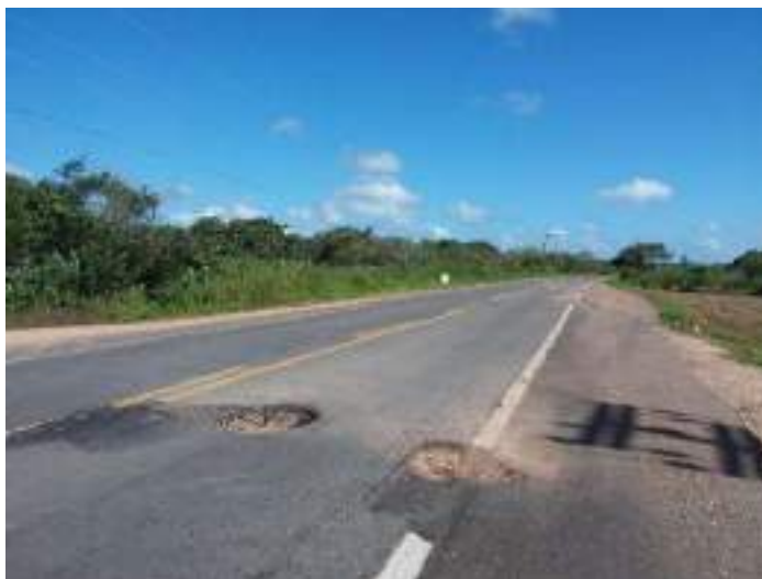
Figura 4 - Trecho rodovia CE-085 em 04/06/2019 - Acaraú, CE
