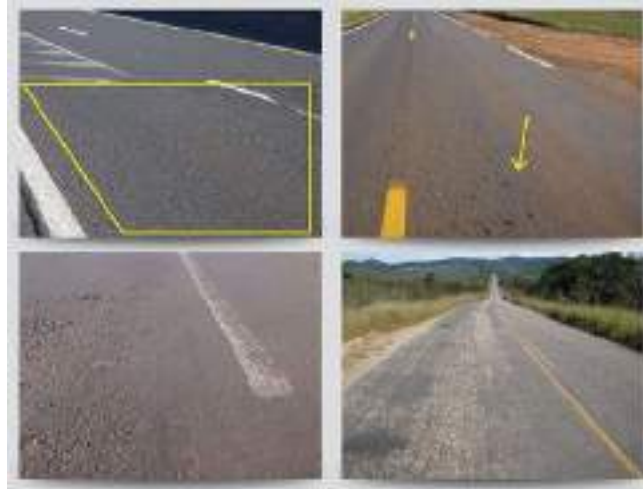
Figura 26 - Desgaste
