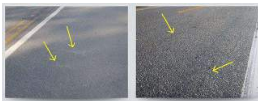
Figura 16 - Fissura
