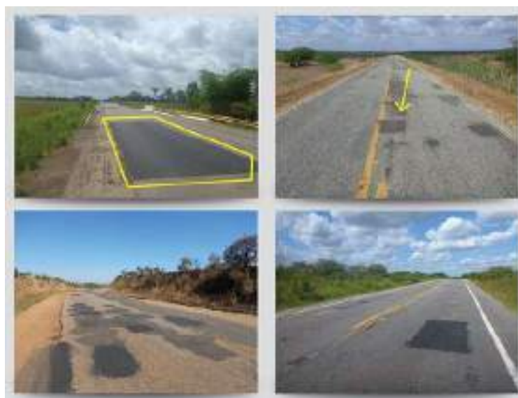
Figura 28 - Remendo
