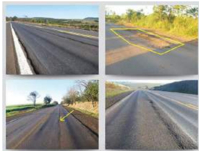
Figura 21 – Afundamento plástico
