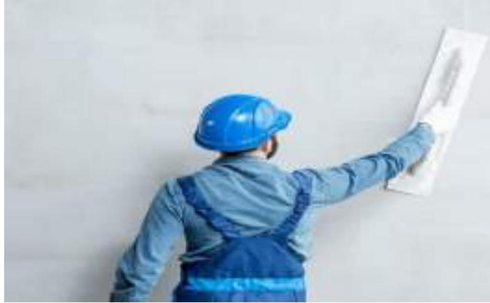
Figura 6 - Aplicação do revestimento.
