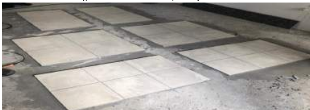
Figura 4 - Placas cerâmicas após o rejuntamento.
