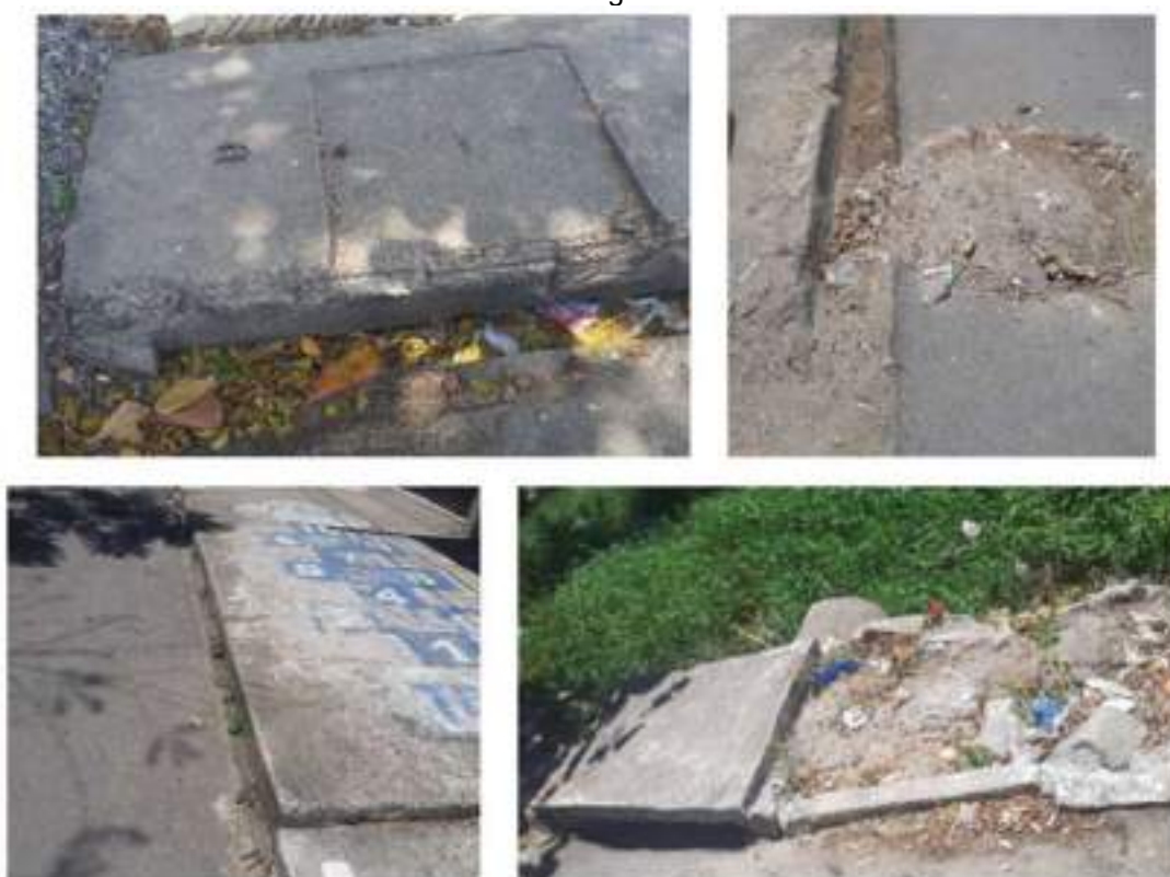
Figura 9 - Comprovação da medida não-estrutural Limpeza e Desobstrução de dispositivos de Drenagem
