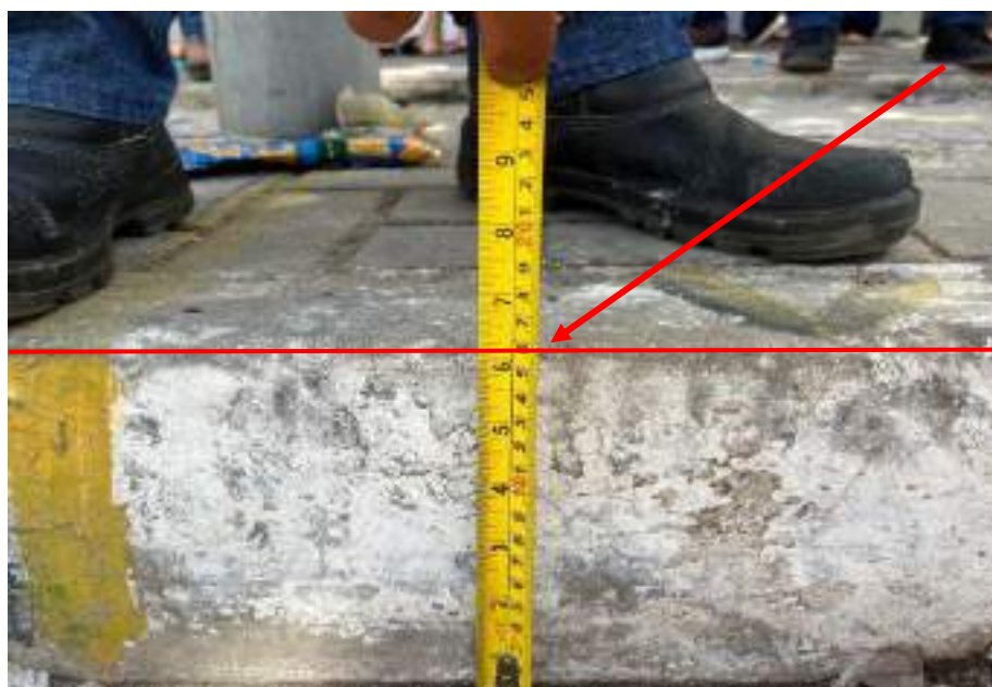
Figura 29 - Altura do meio fio da Rua José Avelino
