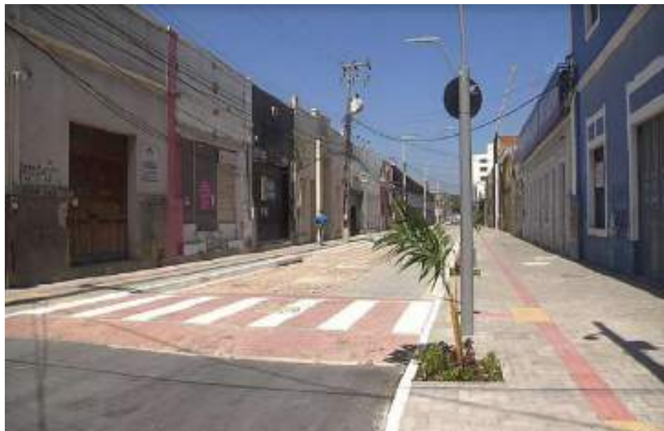
Figura 6 - Rua Jose Avelino após a reforma
