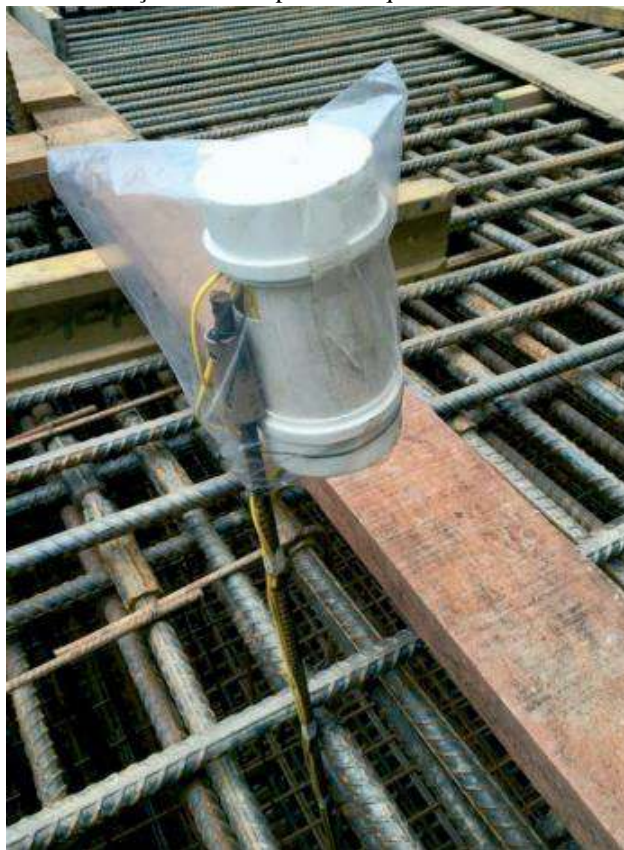
Figura 21 – Detalhe da fixação do termopar e do aquisitor de dados na armação da sapata.
