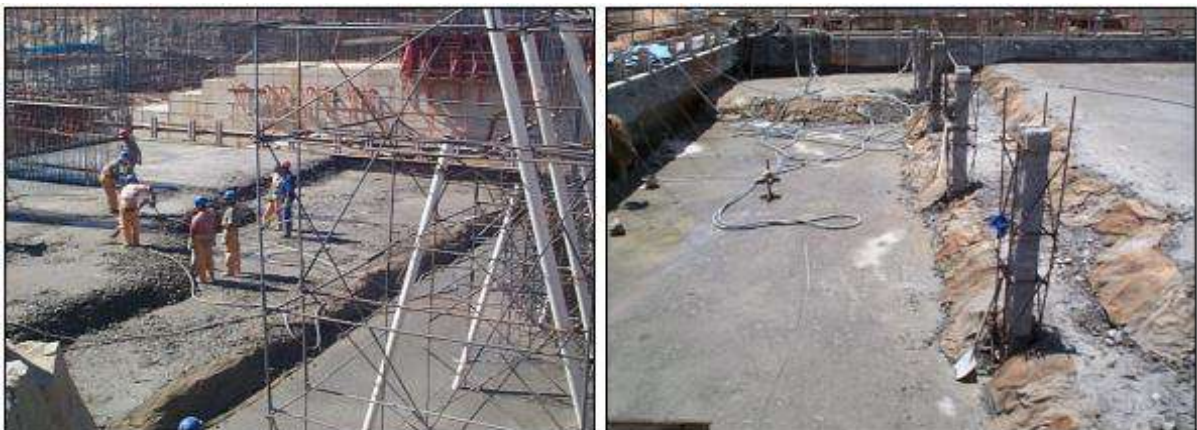
Figura 16 – Exemplo de lançamento do concreto por camadas.
