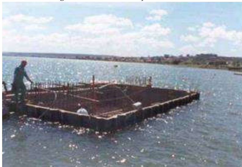
Figura 3 – Bloco de fundação da Ponte JK.
