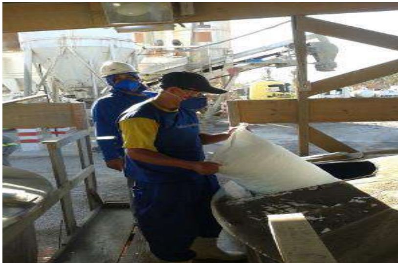
Figura 10 – Gelo em escamas sendo adicionado a massa de concreto.
