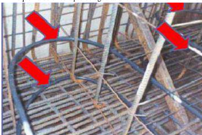
Figura 12 – Esquema de circulação de água através de tubos no interior do concreto.
