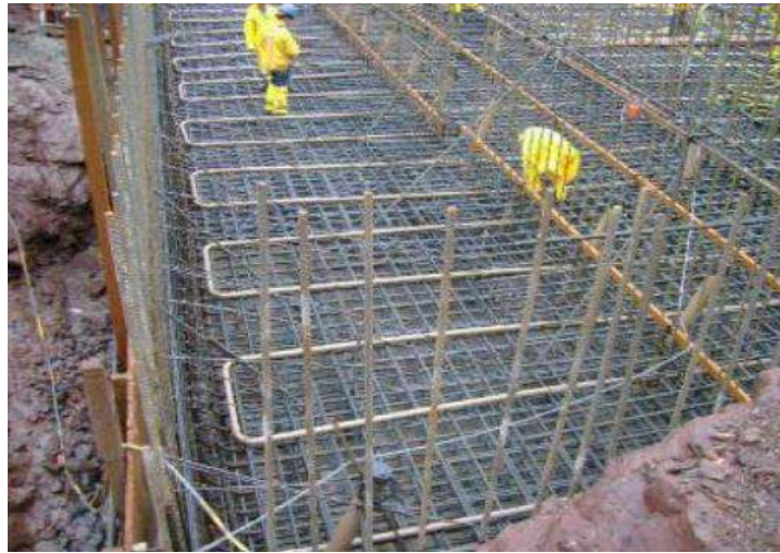
Figura 13 – Uso de serpentina pós-resfriamento de concreto.
