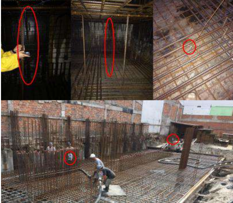
Figura 22 – Instalação dos termopares para monitoramento térmico do bloco de fundação.
