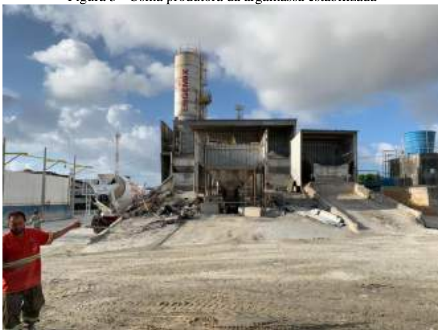
Figura 3 - Usina produtora da argamassa estabilizada
