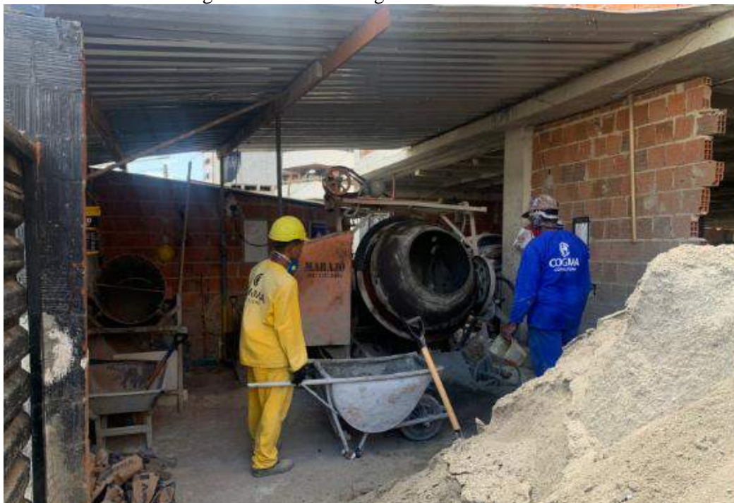
Figura 4 - Betoneira argamassa convencional
