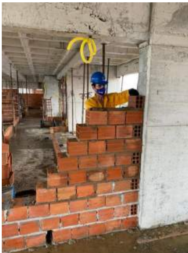
Figura 2 - Alvenaria de bloco cerâmico.
