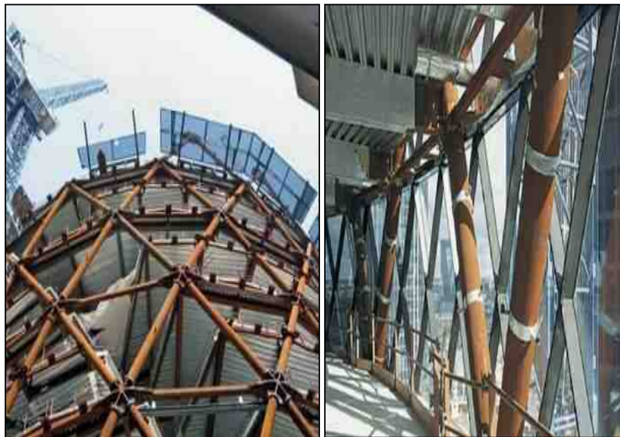
Figura 11 - Edifício St Mary Axe situado em Londres
