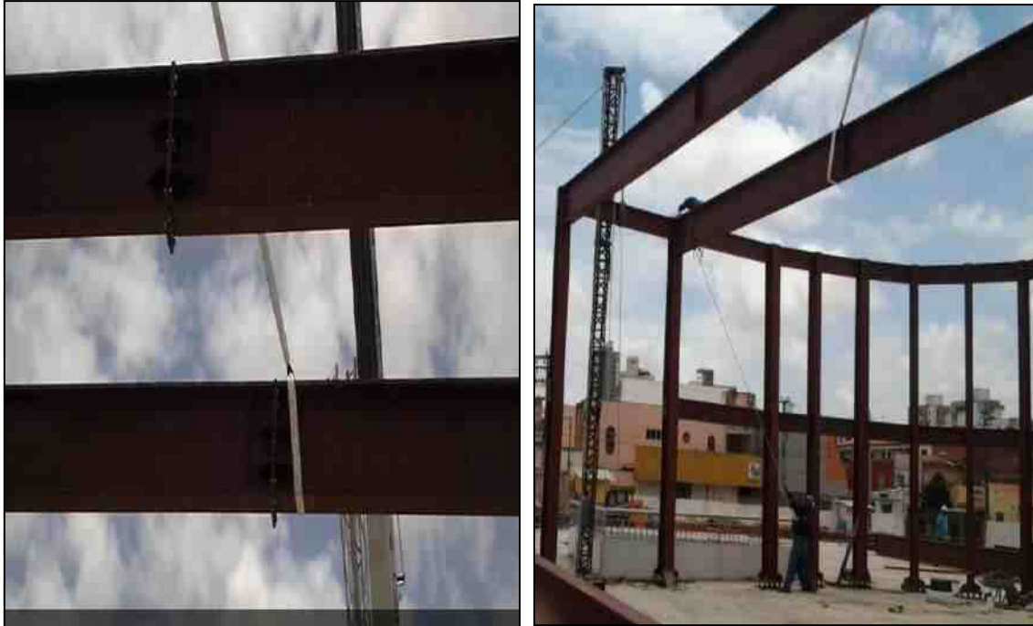
Figura 22: Viga do Auditório no período da construção
