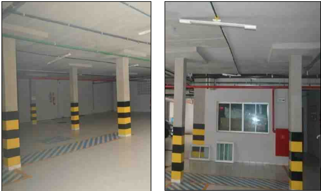
Figura-18 Duas vistas do interior do subsolo , garagem do edifício CREMEC
