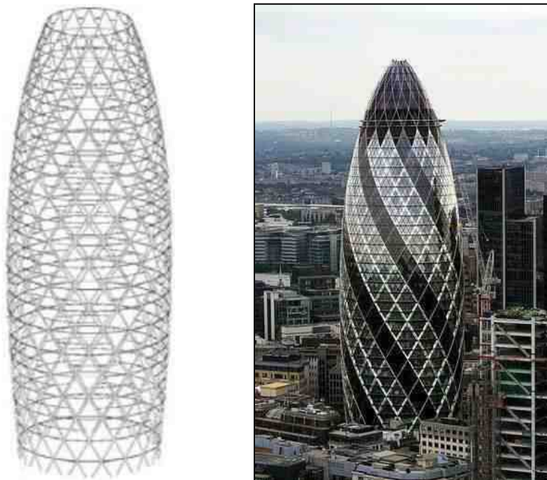
Figura 12 - Sistema Diagrid do Edifício 30 St Mary Axe – Londres
