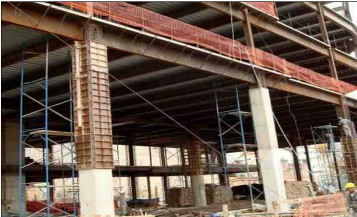
Figura 5 - Aplicação dos sistemas mistos em estruturas verticais
