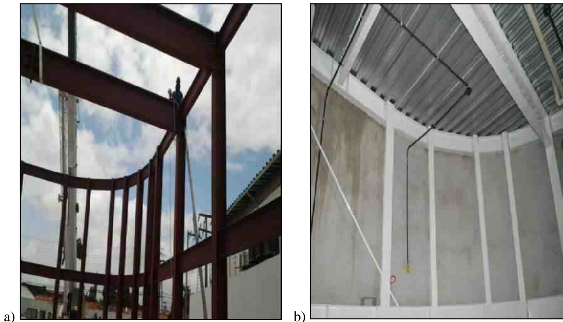
Figura-17 a) Construção da estrutura do auditório, b) vigas e pilares , e laje steel deck.
